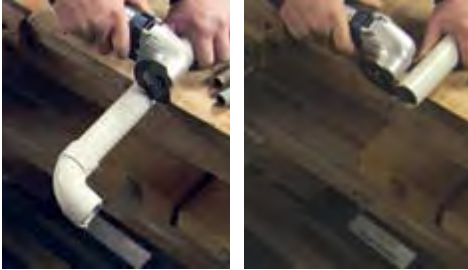
Schneiden von Plastikrohren
