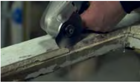
Entfernen von Spachtelmasse
