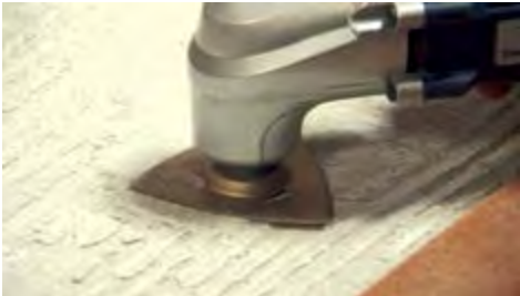
1. Entfernen von schwerem Mörtel
